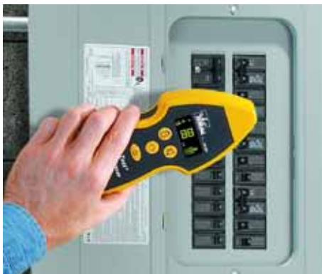
Im Sicherungs-Modus erkennt der Empfänger den Stromkreis, an den der Sender angeschlossen ist.
